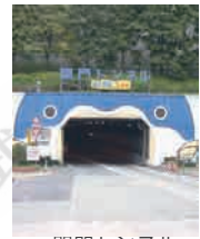
関門トンネル
